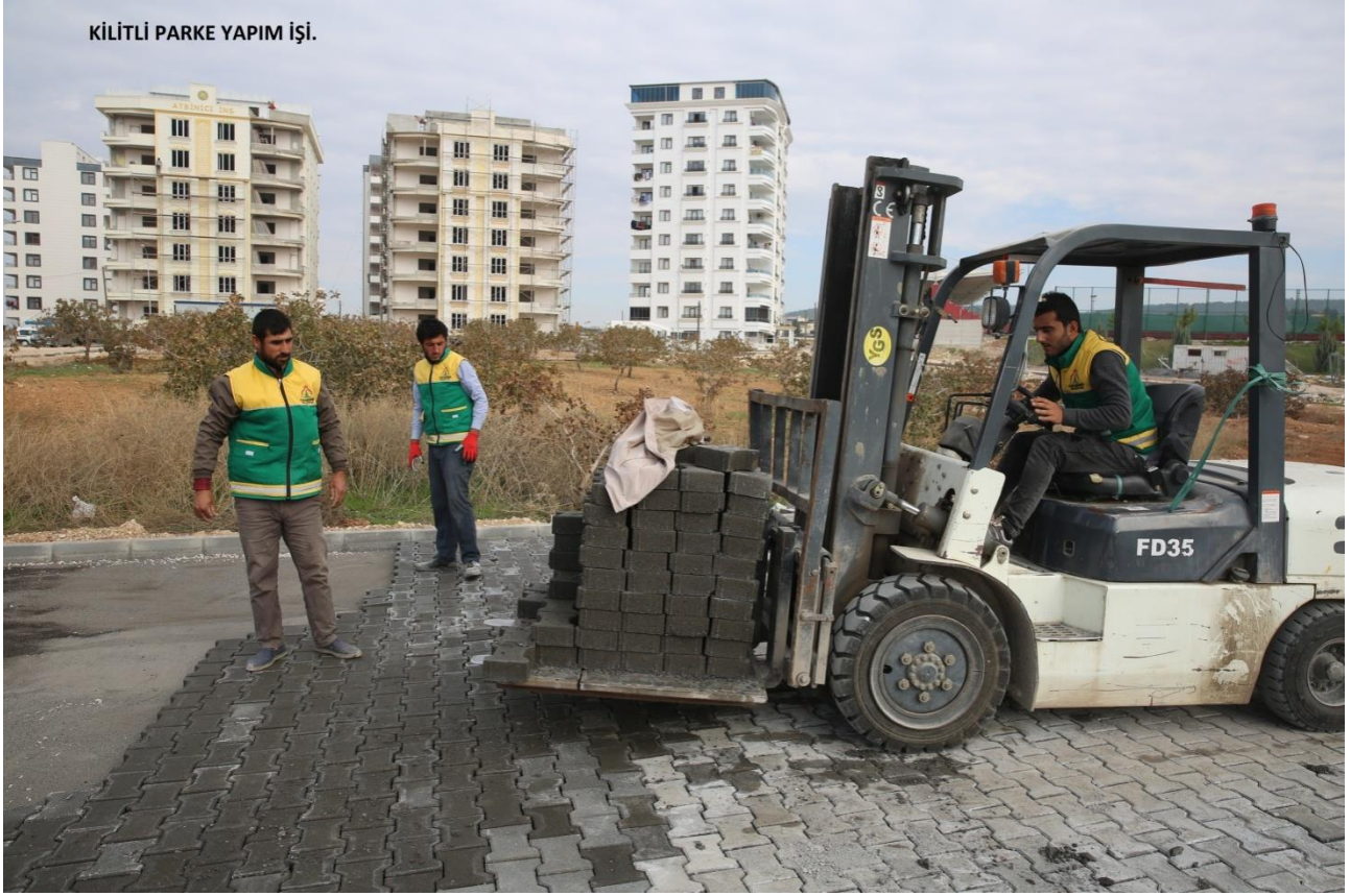
KİLİTLİ PARKE YAPIM İŞİ.
